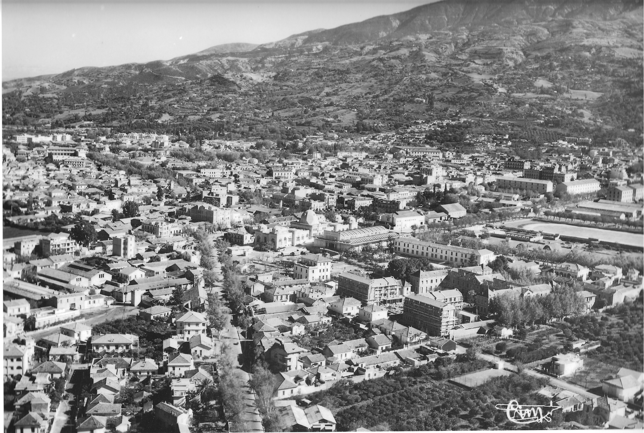
Vue d'ensemble - La halle aux tabacs - Le marché aux légumes - L'école Bonnier - Le stade Duruy - 65 e RAA - 1 er RTA L'église St-Charles - Av. Sergent-Maginot (av. de La Chiffa) - Rue Jean-de-La Fontaine.
