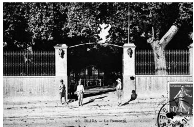
Entrée de la Remonte de Blida
